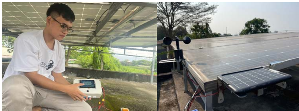
Hình 6. Khảo nghiệm bộ thu với hệ thống 3 kWp
