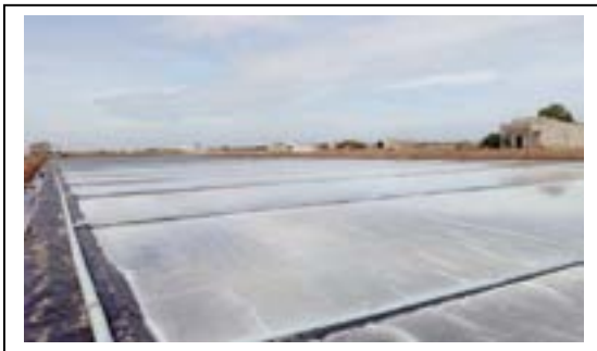
Hình 3.7: Hồ chứa nước chạt và ô kết tinh muối sạch đã được xây dựng
